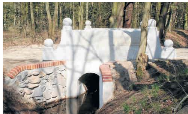
Mostek ACHA w pełnej krasie. Woda i mostki stanowią ważny element zatońskiego parku
