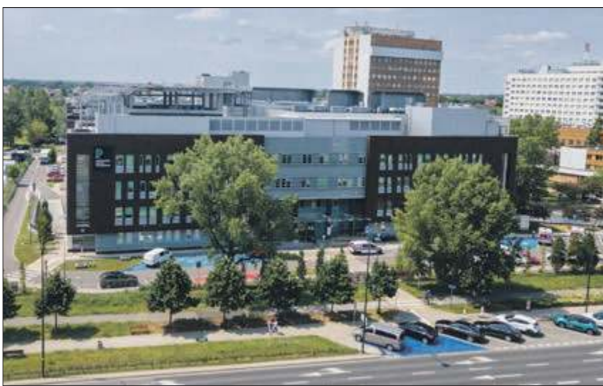
Do zapowiedzi zmian skłoniła rząd aferą w Szpitalu Południowym w Warszawie
