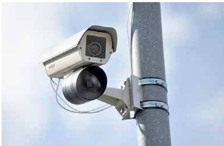
W początkowym etapie ma zostać zainstalowanych 28 kamer monitoringu
