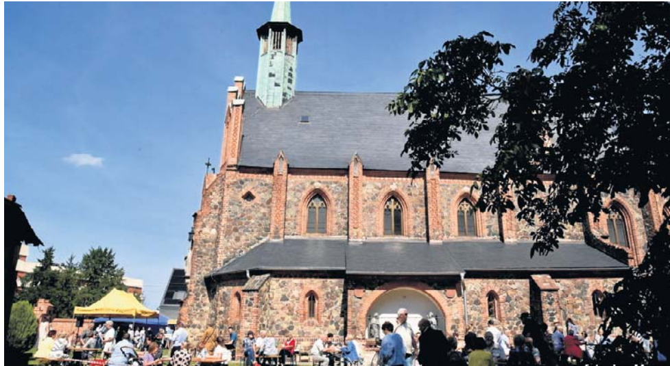
Kościół św. Krzyża w Żaganiu wymaga remontu. Trwa zbiórka na dokumentację i prace konserwatorskie
