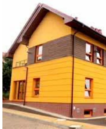
Budowa noclegowni przy ulicy Krasińskiego została zakończona i rozliczona
