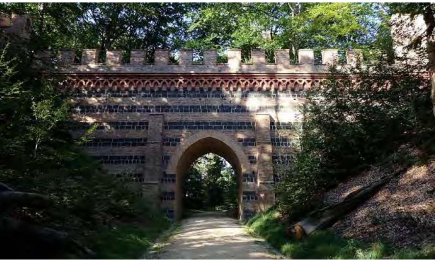
Przypominający bramę warowną wiadukt, stanowiący wschodnie wejście na teren Parku Mużakowskiego
