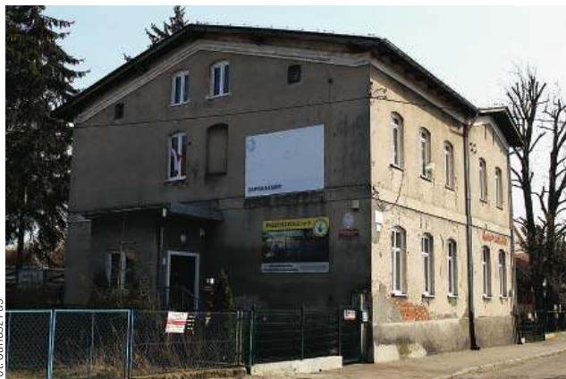
Budynek Przedszkola nr 5 przy ul. Szańcowej w Elblągu również nie spełnia norm w zakresie ochrony przeciwpożarowej
