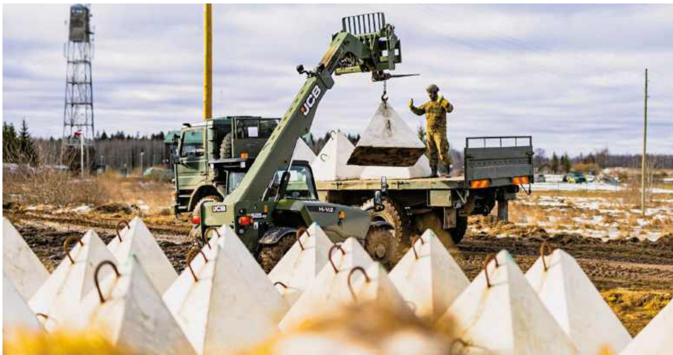
Rozpoczęcie prac na łotewskim odcinku Bałtyckiej Linii Obrony.
