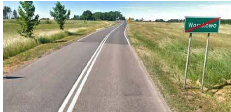
Brakujący odcinek zostanie wybudowany pomiędzy Warnkowem a Karskiem
