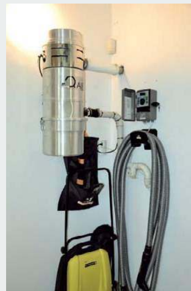
❷ Przy urządzeniu znajduje się tłumik i wyrzutnia powietrza.
