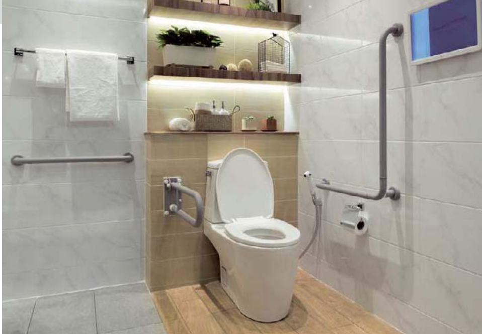
❗ Niezbędnym wyposażeniem łazienki są różnego rodzaju uchwyty, np. przy WC, w strefie prysznica, pomocne przy codziennej toalecie. DEPOSITPHOTOS
