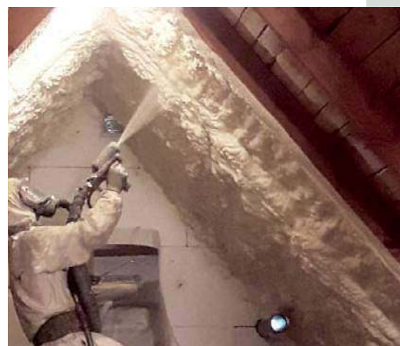
🔗 Nałożenie pianki natryskowej z agregatu zajmuje znacznie mniej czasu niż tradycyjne metody ocieplania. Ponadto fachowo zaaplikowana pianka idealnie wypełnia wszystkie zakamarki. WWW.PURSYSTEM.PL
