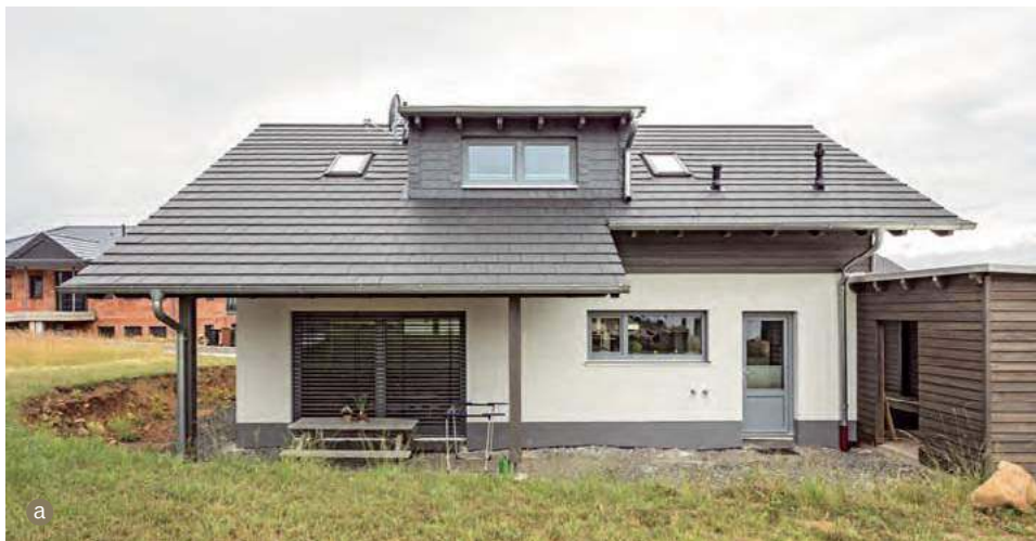
➊ Różne dachówki z bliska: hit ostatnich sezonów, czyli szara dachówka płaska, w tym przypadku ceramiczna (a MONIER BRAAS), układana od stuleci karpiówka (b WIENERBERGER) i wzory z falą, w wersji ceramicznej (c RÖBEN) i betonowej (d MONIER BRAAS).
