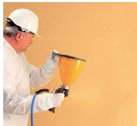
Tynki najwygodniej nanosi się za pomocą agregatu tynkarskiego. LAKMA
