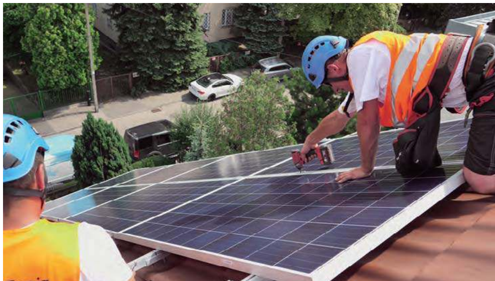
▲ Podstawowe elementy instalacji fotowoltaicznej – panele (a A. PAPLIŃSKI) i falownik (b FRONIUS), przekształcający prąd stały w prąd przemienny.
