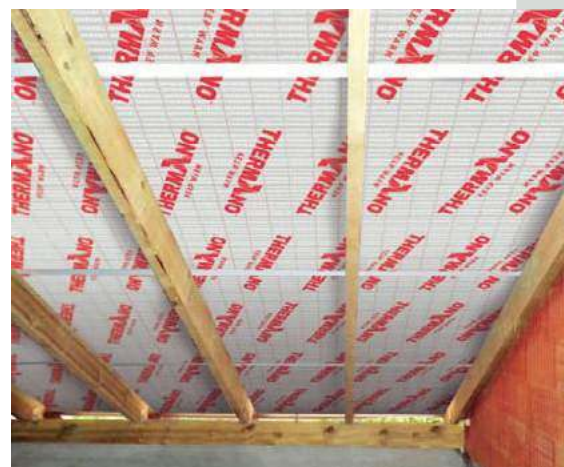
🔗 Układane na krokiewkach sztywne płyty z pianki PUR to jeden z najlepszych materiałów termoizolacyjnych, o niższym współczynniku lambda niż wełna mineralna. THERMANO
