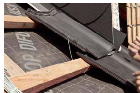
➌ Mocowanie dachówki za pomocą klamry. RÖBEN
