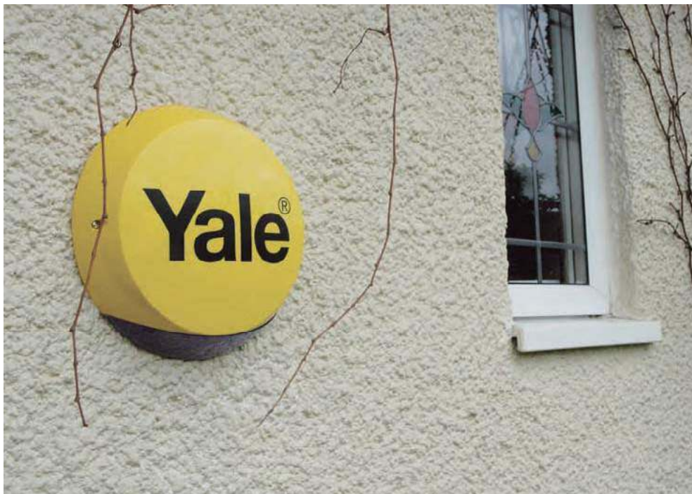
▲ Zadaniem sygnalizatora alarmowego jest powiadomienie osób przebywających w pobliżu domu o wykrytym zagrożeniu. YALE
