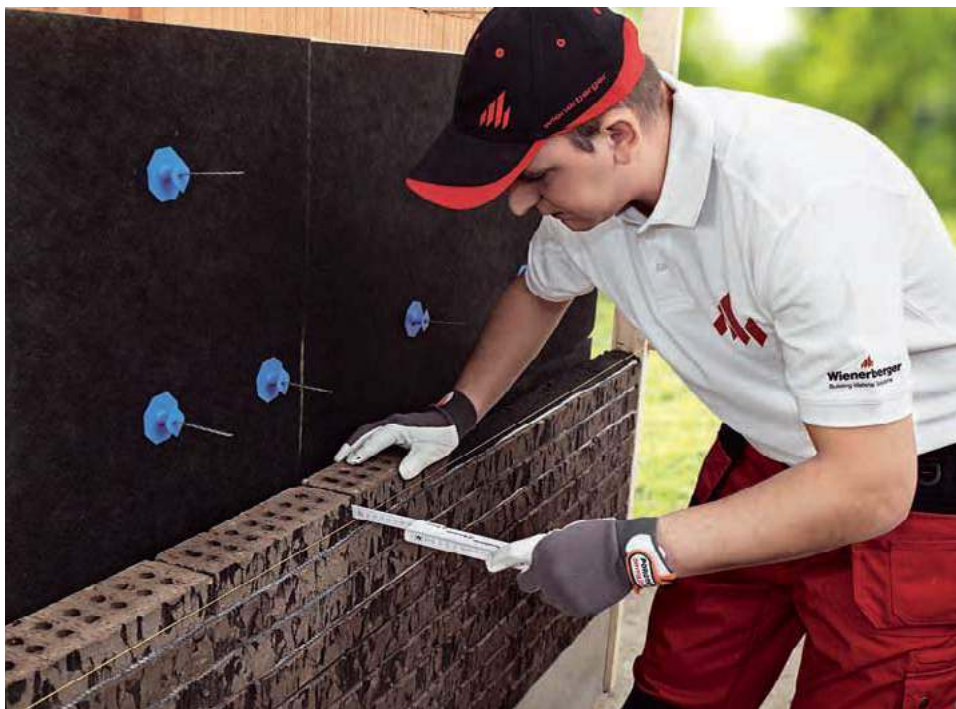
🔧 Także ściany trójwarstwowe mają coraz częściej warstwę nośną z cieplejszej ceramiki poryzowanej. Za to na elewacjach dominuje klinkier. WIENERBERGER
