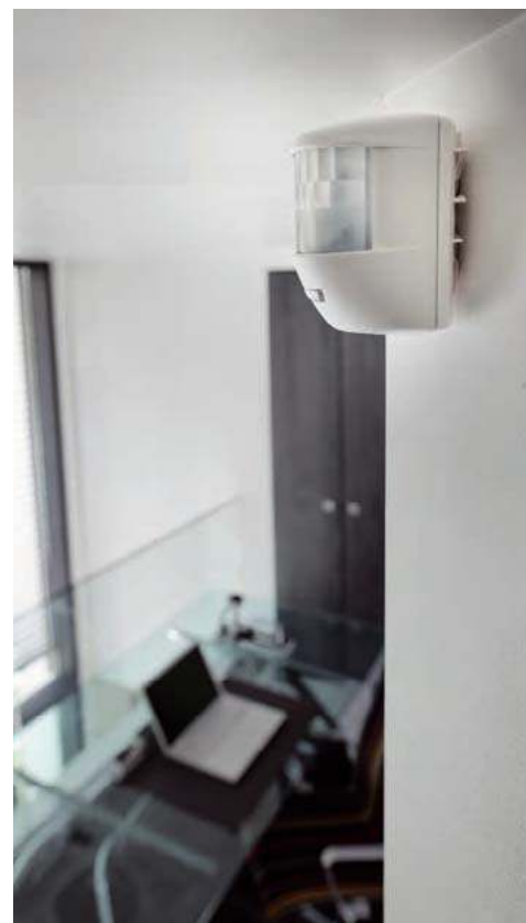
▲ Czujniki ruchu montuje się zazwyczaj w narożnikach pomieszczeń. SOMFY
