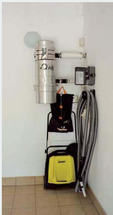
☛ Jednostka centralna z cyklonem wisi na wysokości 1,5 m.
