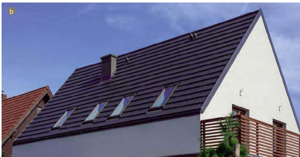
➋ Dla niewprawnego oka pokrycia ceramiczne i betonowe są nie do odróżnienia. Tu dachówki płaskie, na jednym dachu z betonu (a), na drugim ceramiczne (b). CREATON POLSKA
