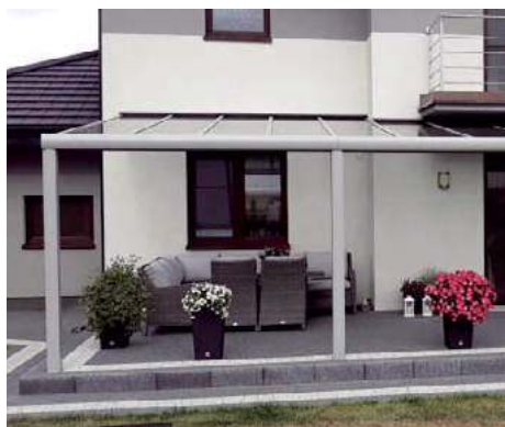
📍 Konstrukcja szklanego zadaszenia to najczęściej aluminium. NEXHED
