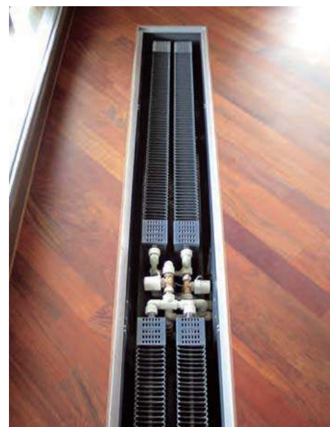
▲ Grzejniki kanałowe ukrywa się w podłodze. Jednak, inaczej niż podłogówka, reagują one bardzo szybko na zmiany zapotrzebowania na ciepło. REGULUS-SYSTEM
