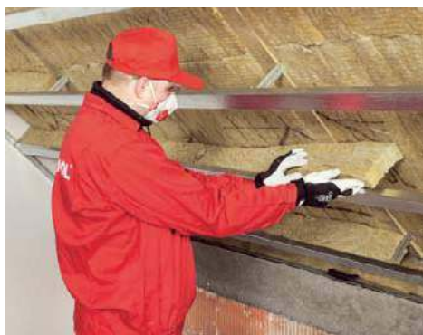
🔧 Stalowe profile rusztu należy wypełnić paskami wełny mineralnej. Inaczej będą mostkami termicznymi. ROCKWOOL
