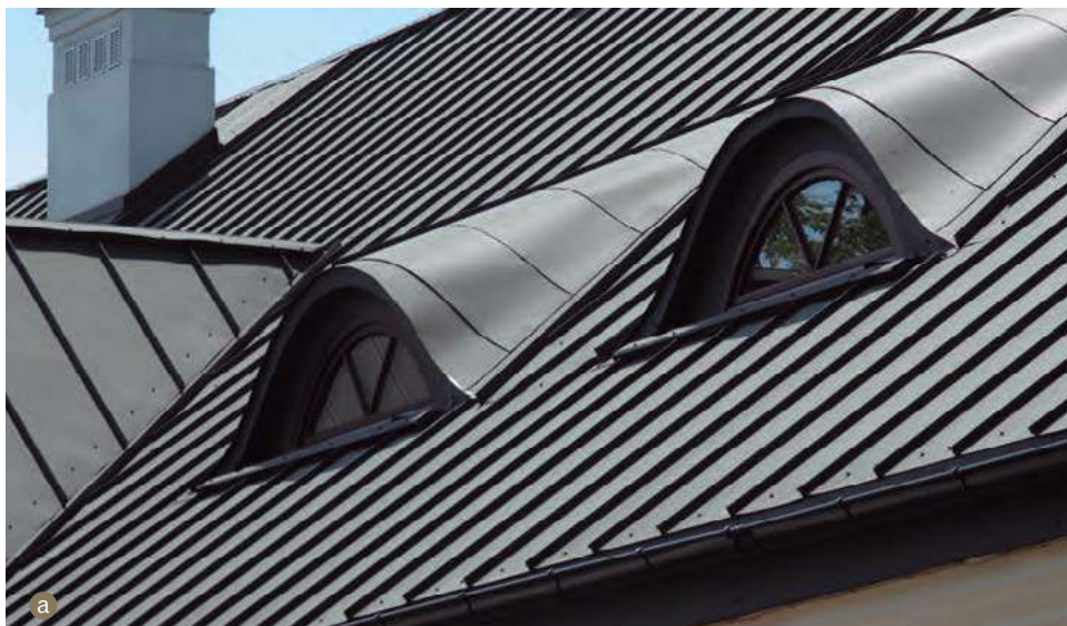
❶ ➔ Blacha płaska łączona na rąbek (a RUUKKI) i jako gotowe panele karo (b BLACHY PRUSZYŃSKI).
