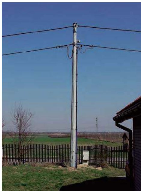
i Odległość pomiędzy linią średniego napięcia i zbiornikiem z gazem musi wynosić aż 15 m. To poważne ograniczenie dla możliwości jego lokalizacji. J. ANTKIEWICZ
