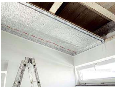
🔹 Wielowarstwowa mata z folii aluminiowej odbija promieniowanie ciepłe z powrotem do wnętrza. ALUTHERMO
