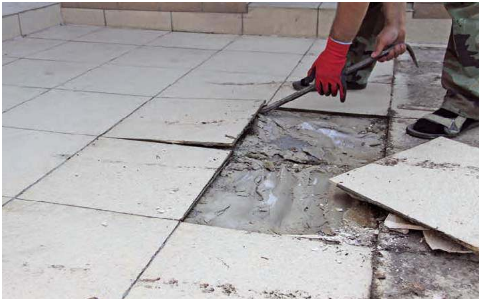
i Podczas usuwania pojedynczych uszkodzonych płytek ceramicznych trzeba uważać, aby nie uszkodzić zarówno sąsiednich elementów nawierzchni, jak i warstw izolacyjnych. J. WERNER
