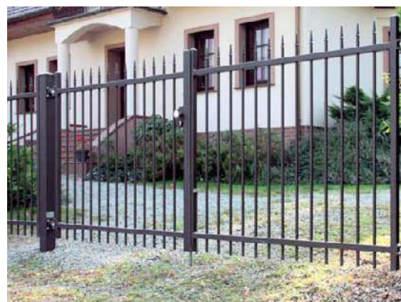
❷ Ogrodzenie ze stalowych profili jest proste, ale szykowne. Warto zrobić je, jeśli chcemy pochwalić się domem i ogrodem. PLAST-MET
