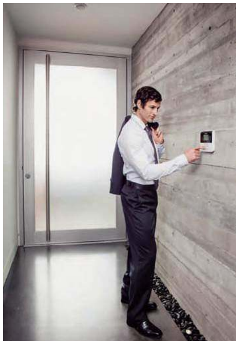
▲ Urządzenia sterujące, takie jak manipulatory, umieszcza się w zazwyczaj w pobliżu drzwi wejściowych do domu. BOSCH SECURITY
