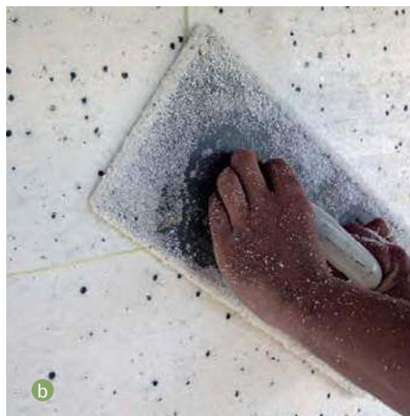
🔪 Drobne szczeliny zwykle wypełnia się pianką. Po jej stwardnieniu odcina nadmiar (a) i całość przeszlifowuje (b). ŚNIEŻKA (FOVEO TECH)
