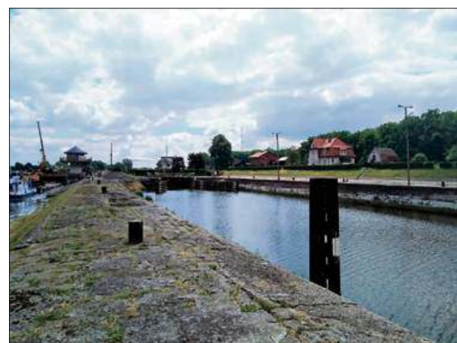
Zakończenie inwestycji planowane jest na październik 2023 roku.
