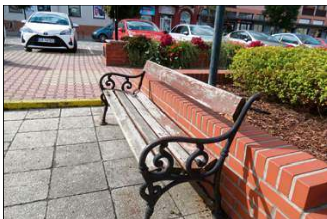
Wymieniono tylko brakujące i połamane deski. Te spróchniałe i obłazające z farby oceniono najwidoczniej jako „jeszcze dobre”.
