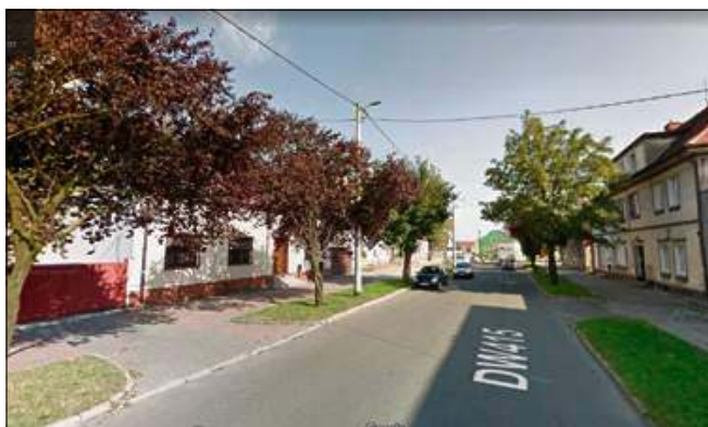
Tak wyglądała Opolska przed modernizacją - ulica zniszczona, ale zieleni za to przepiękna.
