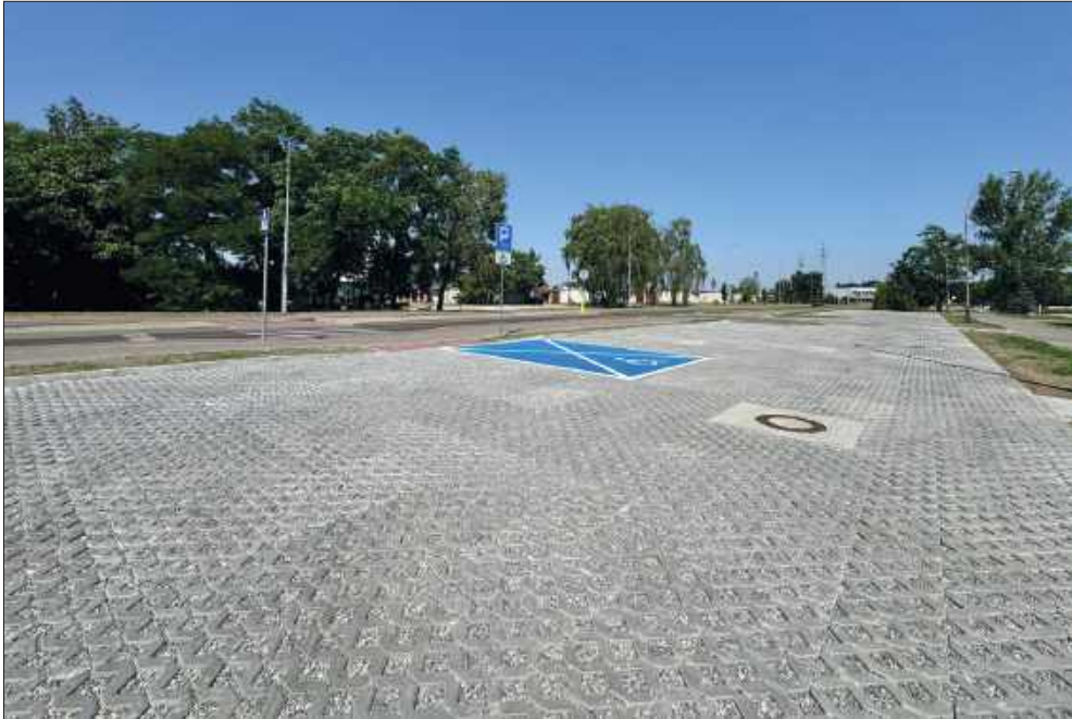
Koniec prac przy Jagiellończyka. Nowy parking gotowy!
