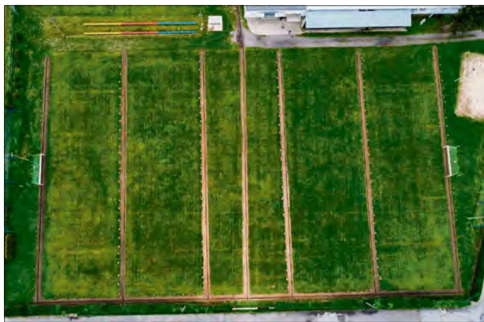
Prace instalacyjne wymagały wielu przygotowań.
