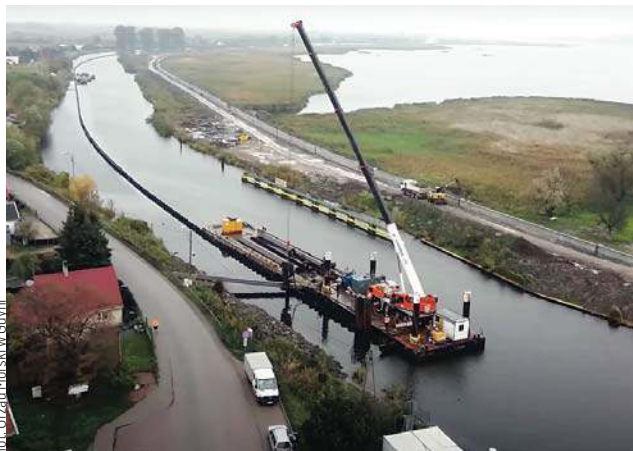
Pogrążanie grodzic na rzece Elbląg, brzeg zachodni
