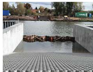
Zejście dla zwierząt, brzeg zachodni
