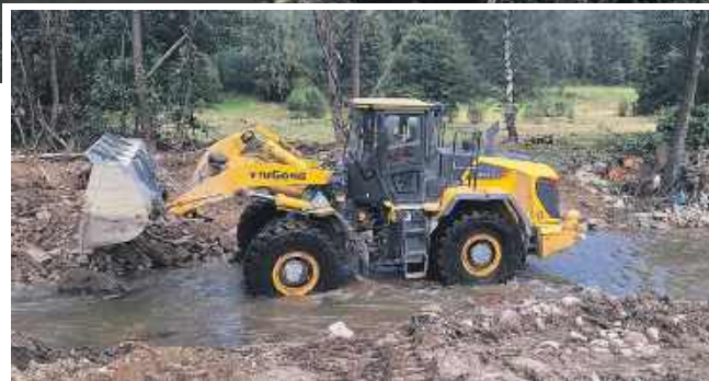
Ładowarka ze Stalowej Woli przy pracach w korycie rzeki Morawy
