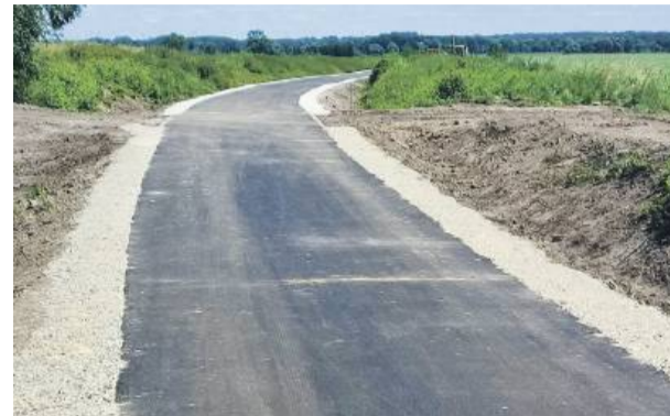
To początek trasy widziany z drogi Strzelin – Chociwel. Nawierzchnia asfaltowa ma 3 metry szerokości, a pobocza utwardzone są kamiennym kruszywem
