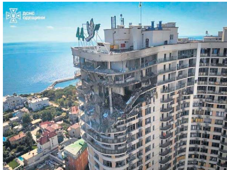
Rosjanie atakowali Odesę w nocy z soboty na niedzielę. Uszkodzono m.in. placówkę edukacyjną i wielopiętrowy budynek
