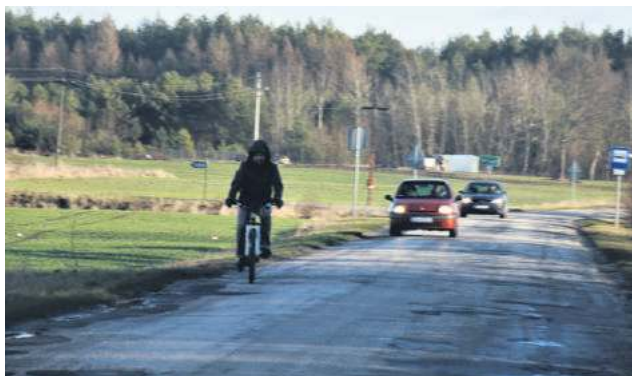
Kłopotem jest wąskie pobocze, a właściwie jego brak.
