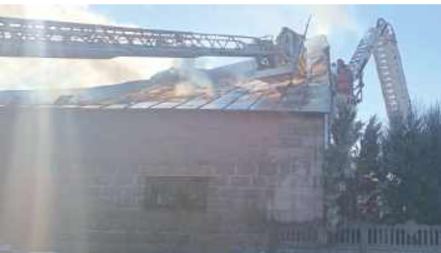
Prawdopodobną przyczyną pożaru było zwarcie instalacji elektrycznej
