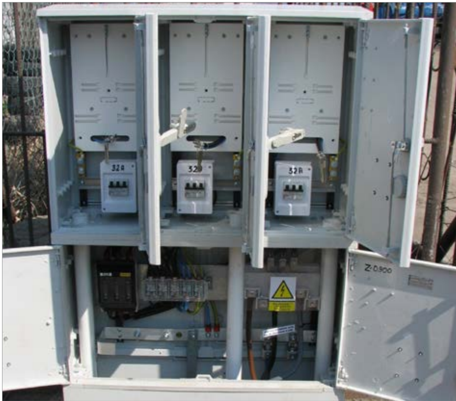
Fot. 3. Przykładowe zastosowanie ograniczników mocy ETIMAT T w rozdzielnicach
