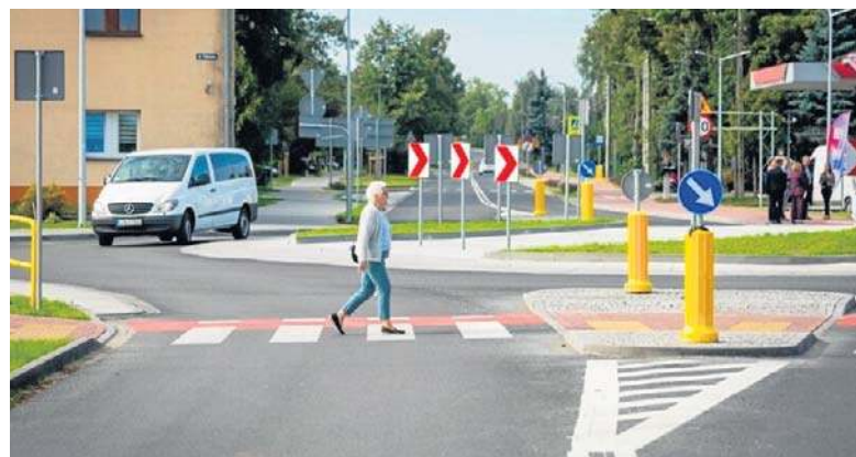
Tak po przebudowie wygląda rondo w Barcinie
