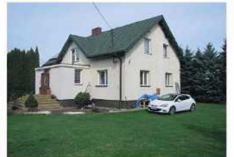
Widok budynku mieszkalnego od strony południowo-wschodniej.
