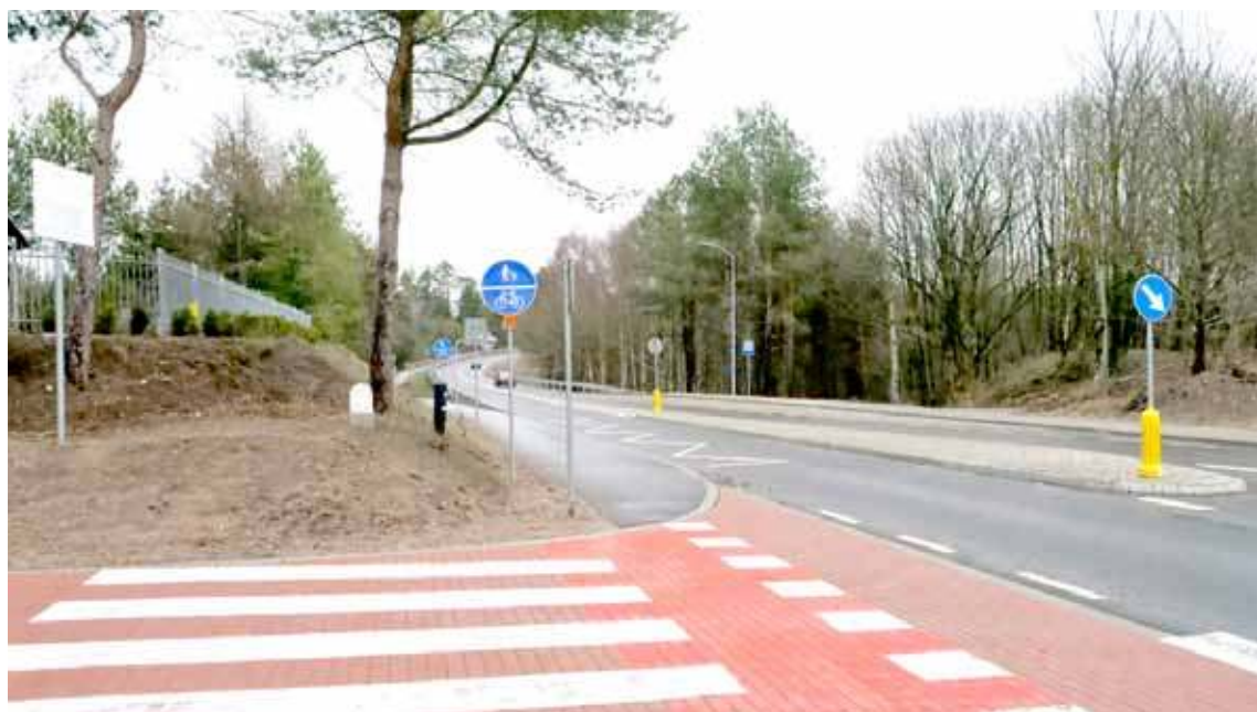
Prawie siedmiokilometrowy odcinek Ińsko – Ciemnik został poszerzony z 6 do 7 metrów, przebudowano dwa przepusty
