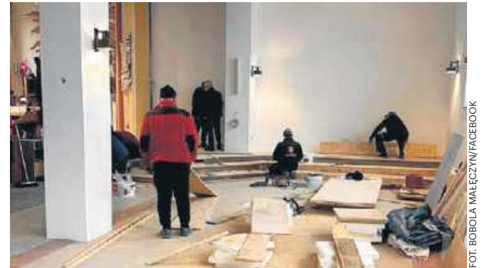
Parafia świętego Andrzeja Boboli w Małęczynie pochwaliła się efektem prac przy rozbudowie.
