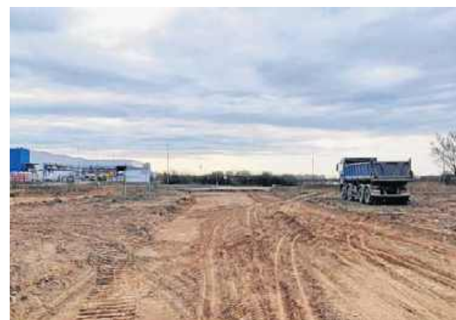
Budowa ostatniego odcinka trasy N-S od ulicy Andersa do Energetyków już trwa.
