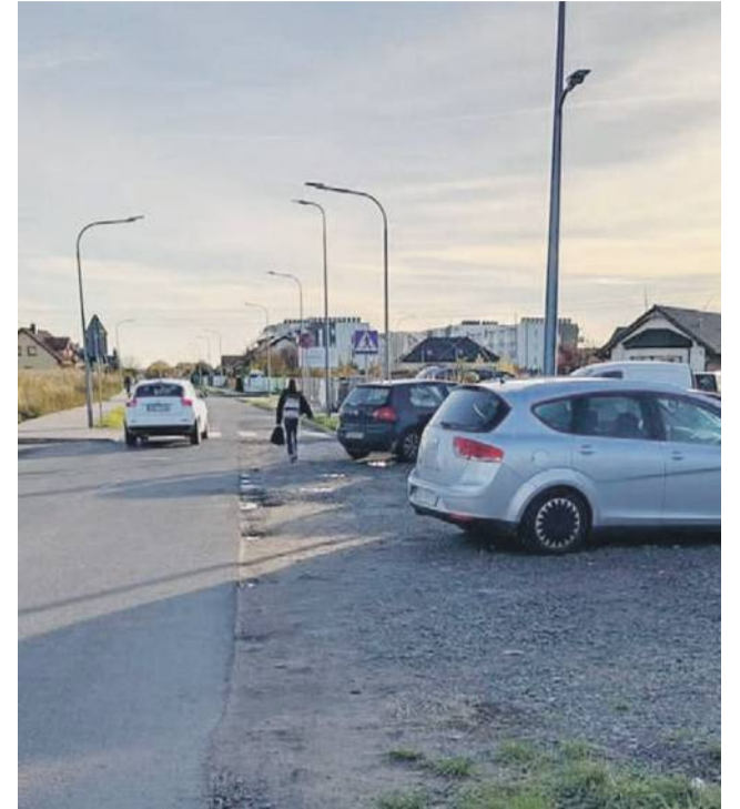
Połączenie starego z nowym aż nadto widoczne
