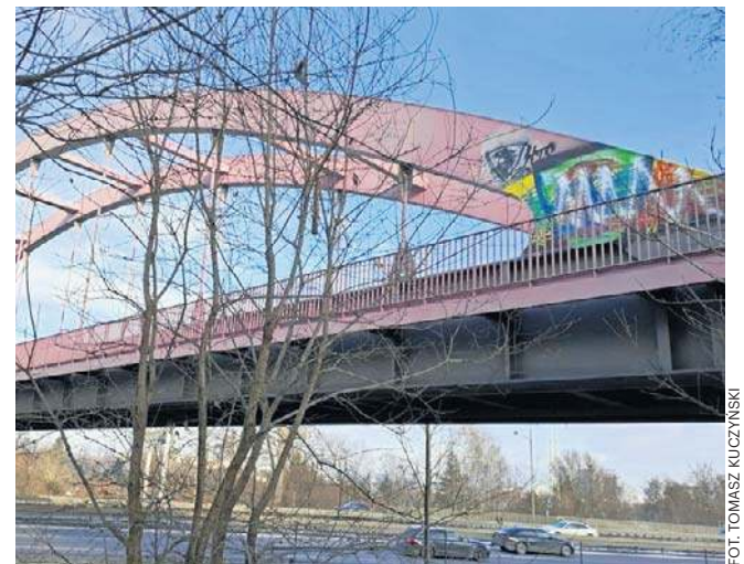
...natomiast z drugiej strony mostu już jest zamalowany
