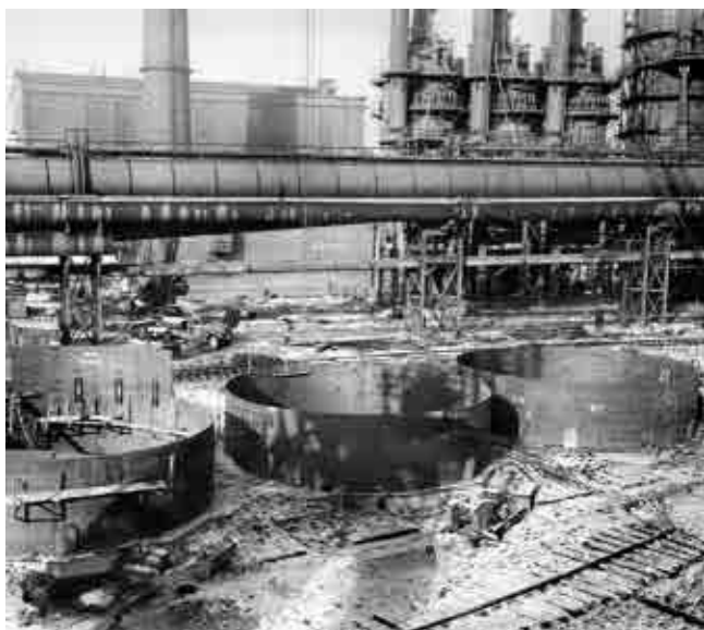
Montaż korpusu Wielkiego Pieca nr 3, widoczne stalowe korpusy (cargo) – prawdopodobnie rok 1956
