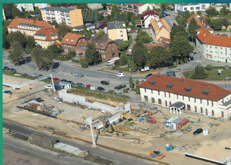
Przebudowa stacji Giżycko
