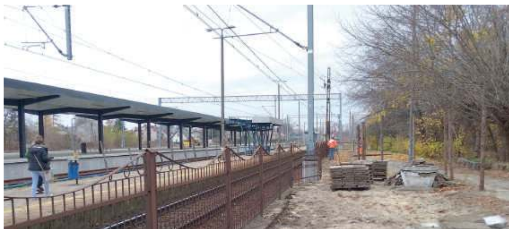
W grudniu 2021 r. wreszcie ma zostać zakończony pierwszy etap modernizacji stacji Białą Podlaska, którego symbolem będzie udostępnienie nowego peronu wyspowego nr 2 w Białej Podlaskiej. W czwartek dwóch robotników kręciło się na białskiej stacji przy zdejmowaniu starych płyt obok dworca
