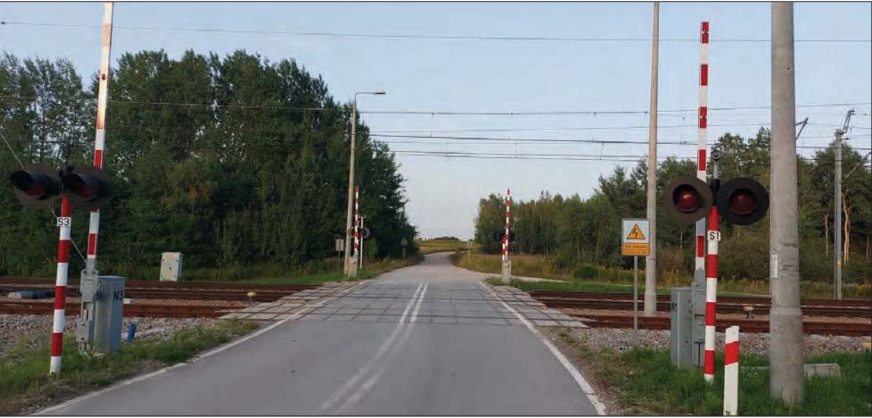
Dyskusja na sesji dotyczyła przejazdu kolejowo-drogowego na końcu ulicy Kolejowej w Łaskarzewie
