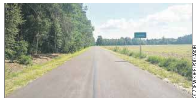
Na końcowy odbiór czeka przebudowa drogi nr 1072L na trasie Łomazy – Kolembrody – Wiski wraz z remontem trasy powiatowej nr 1105L Rossosz – Kozły. Jej łączna długość to ponad 14 km
