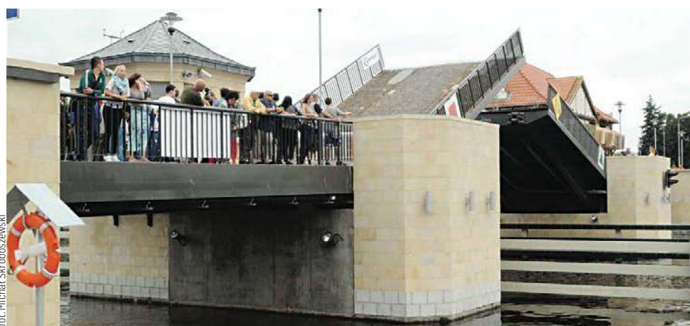
Nowe mosty zwodzone oddano do użytkowania w 2013 roku. Niestety ich stan techniczny od początku stwarzał problemy
