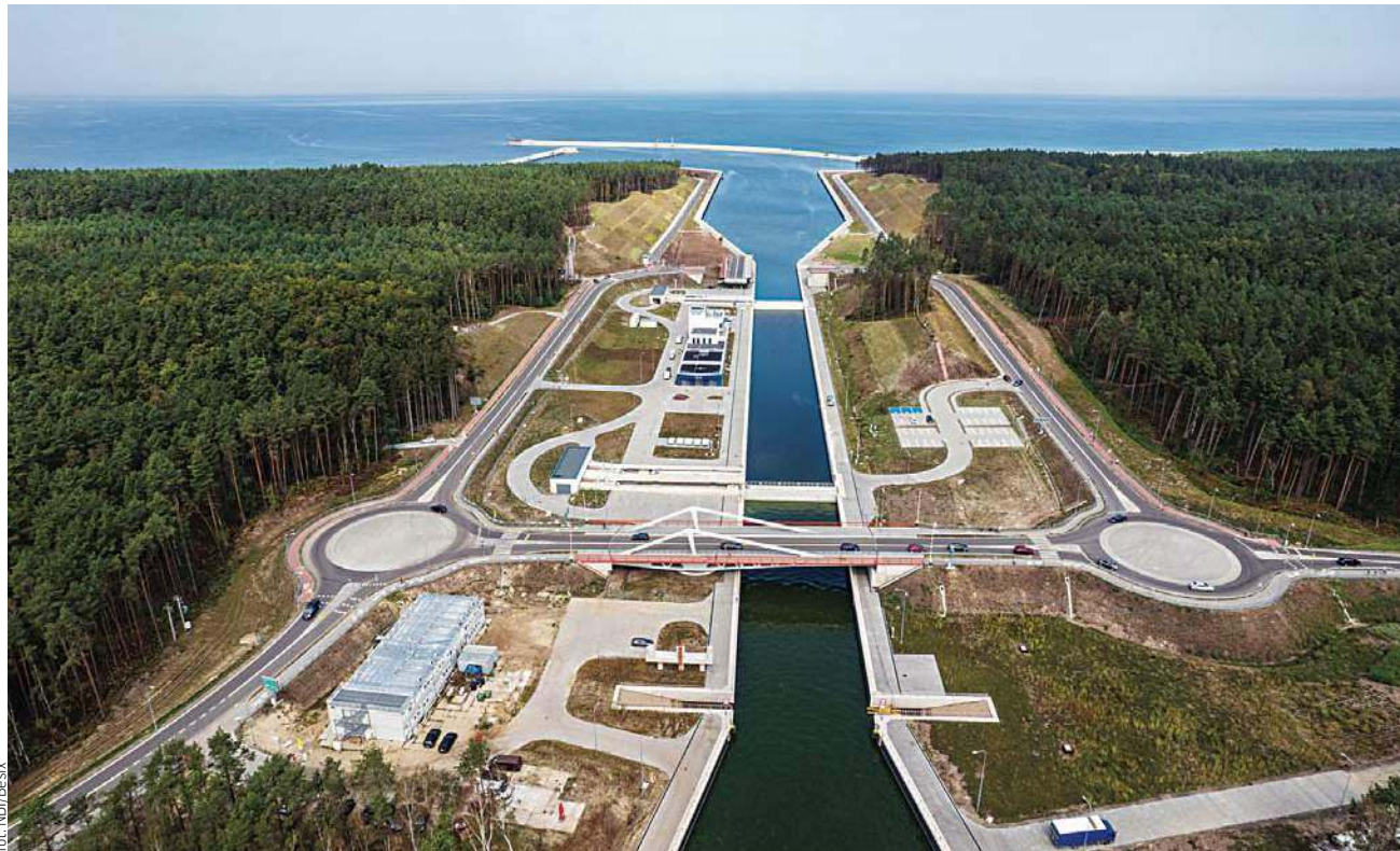
W sobotę 17 września I etap budowy nowej drogi wodnej łączącej Zalew Wiślan z Zatoką Gdańską zostanie oficjalnie zakończony
