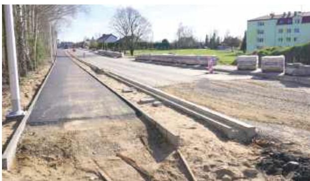
Przy drodze drogowcy równolegle budują chodnik i ścieżkę rowerową
