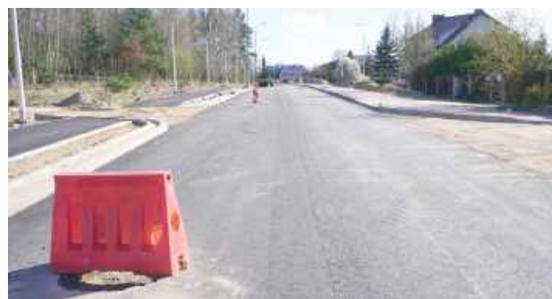
Budowa ul. Powstańców Listopadowych jest możliwa dzięki dotacji uzyskanej przez miasto z Rządowego Funduszu Rozwoju Dróg
