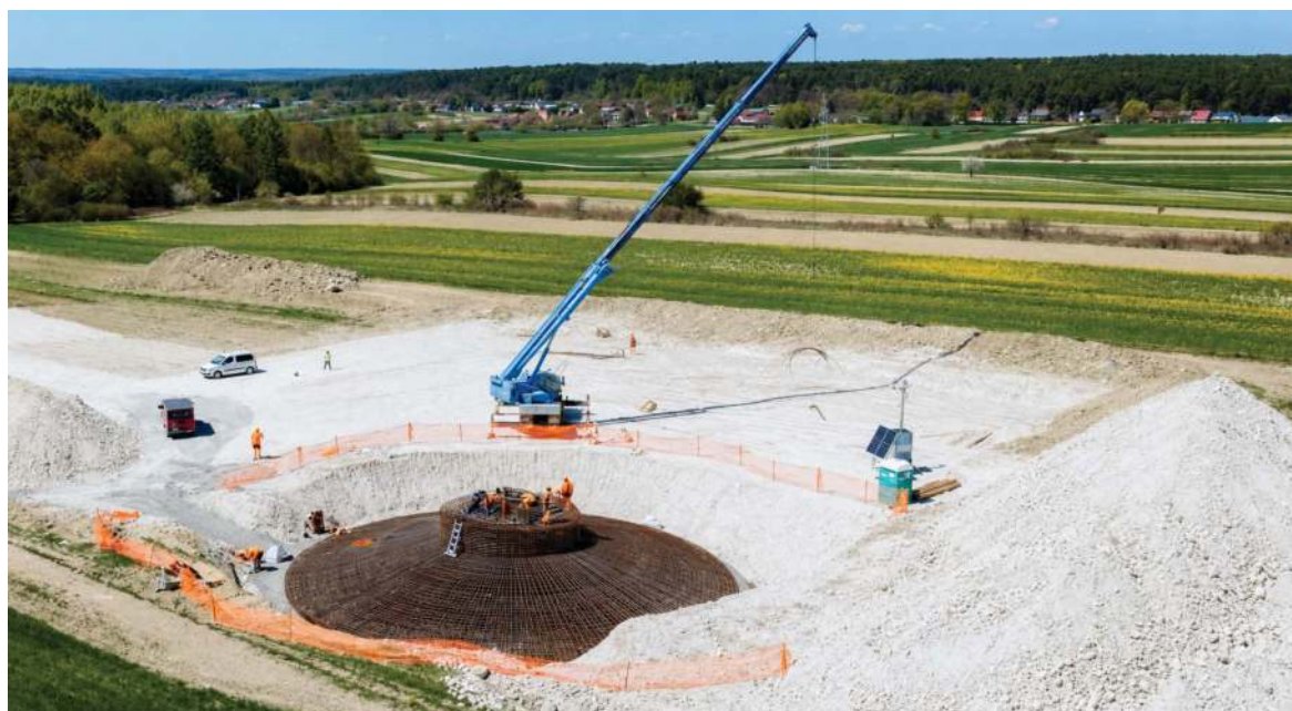
Szwedzka firma O2X zbudowała już niewielką farmę w okolicach Kraśnika. Teraz po sąsiedzku buduje znacznie większą w gminach Gościeradów i Annapol. Fundamenty już gotowe. Niedługo ma rozpocząć się transport wielkogabarytowych elementów wież
