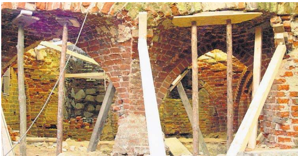
Początkowo uważano, że jest to XIII-wieczna piwnica i chciano ją zasypać
