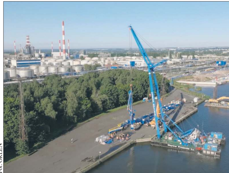
Trwa budowa Morskiego Terminalu Przeładunkowego na Martwej Wiśle
