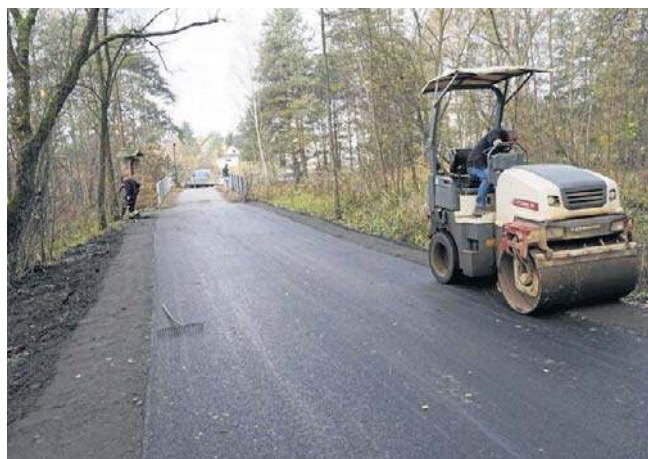
Droga łącząca Zagórze z Żarkami po remoncie. Była w fatalnym stanie
