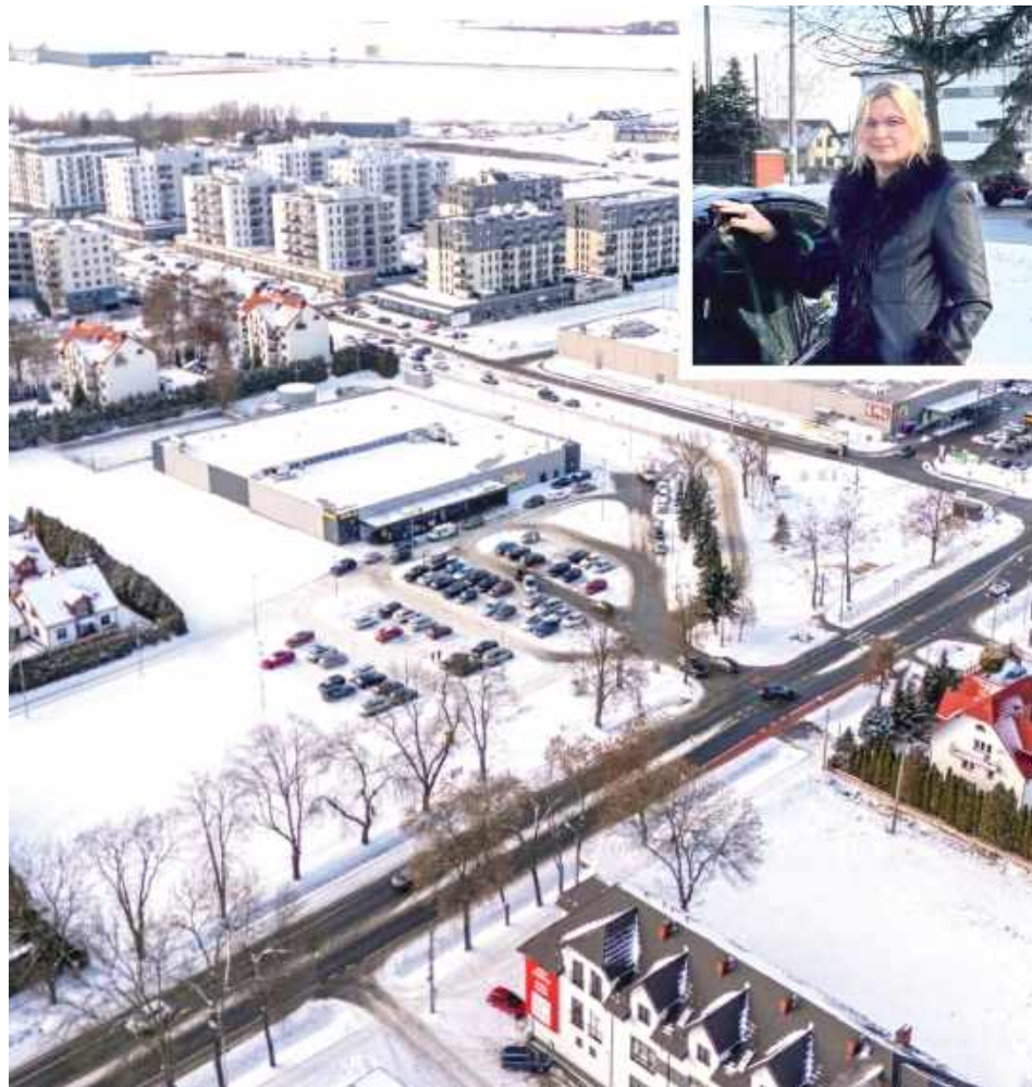
Zakończenie wszystkich etapów budowy ul. Zamojskiej ma znacząco poprawić komunikację w tej części miasta, zwiększyć bezpieczeństwo uczestników ruchu oraz uporządkować lokalny układ drogowy
