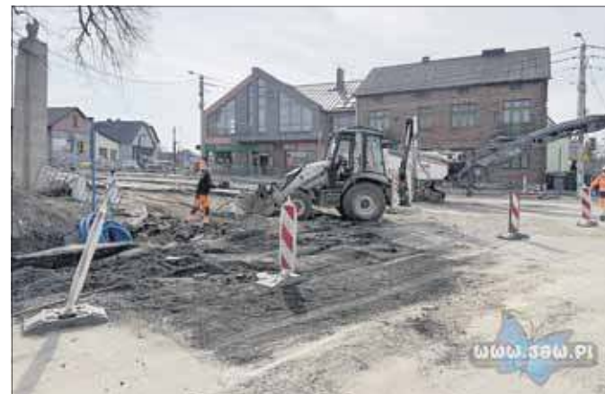
Przebudowa głównego skrzyżowania w Byczynie
