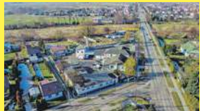
Nieruchomość przemysłowa w Międzyrzecu Podlaskim z istniejącą hurtownią spożywczą i stacją gazu LPG, przy ulicy Warszawskiej, blisko wyjazdu na drogę E 30 (krajowa A2), 665 750 197
