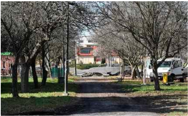
ŚWIDNIK. Modernizacja chodników na finiszu
