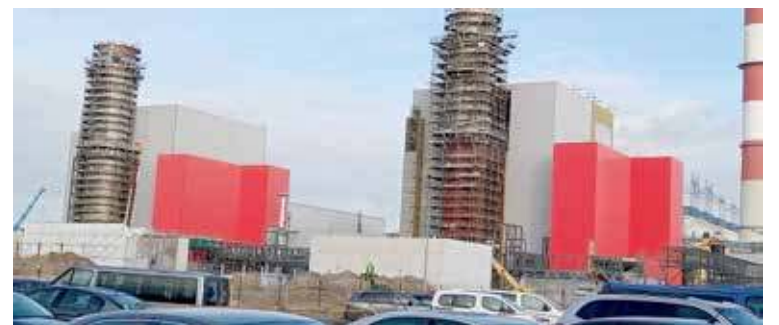
Foto z okresu budowy bloków gazowych
