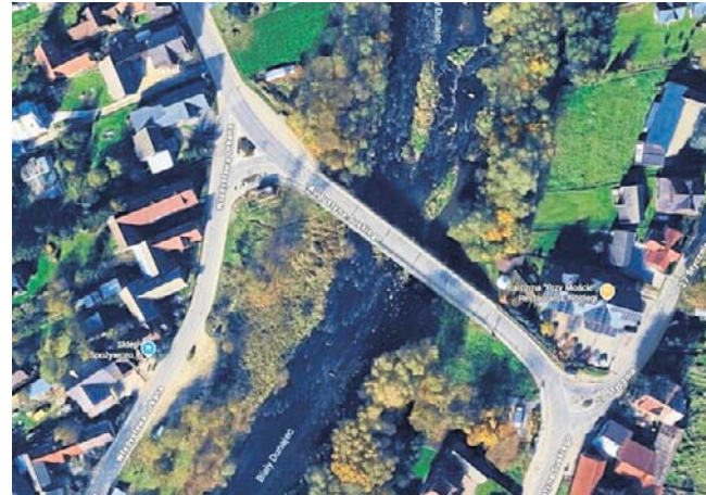
Powiatowy Zarząd Dróg ogłosił wyłączenie z ruchu kołowego przeprawy nad Białym Dunajcem
