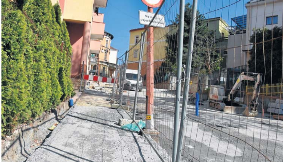
Remont 200-metrowego odcinka ulicy ciągnie się już od września ubiegłego roku
