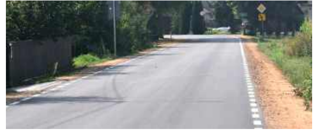
Nowa jakość podróży - droga już odebrana
