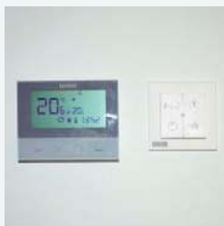
Czteroprzyciskowy sterownik pokojowy znajduje się w holu.
