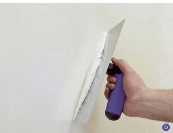
■ Nakładanie gładzi za pomocą pacy (a, b GREINPLAST) i za pomocą agregatu (c BAUMIT).
