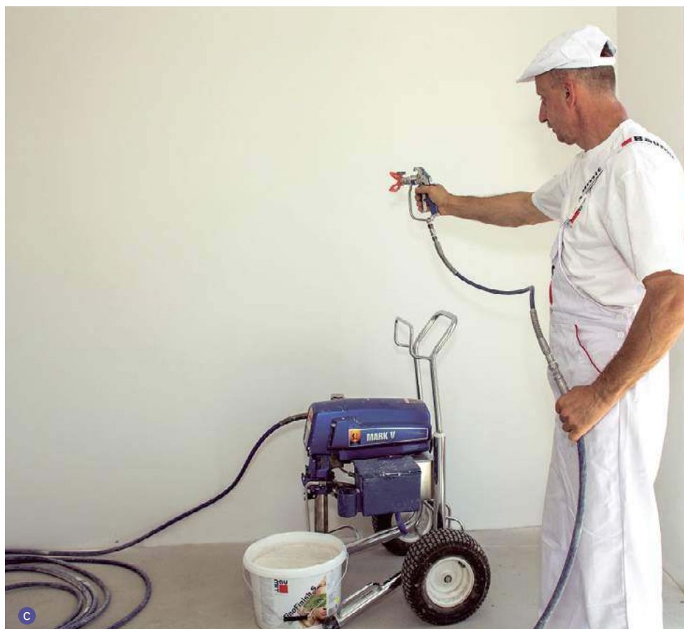
■ Nakładanie gładzi za pomocą pacy (a, b GREINPLAST) i za pomocą agregatu (c BAUMIT).
