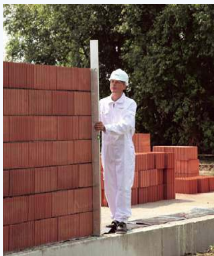
📌 Pustaki z ceramiki poryzowanej obecnie najczęściej służą do budowy ścian dwuwarstwowych. ZCB OWCZARY
