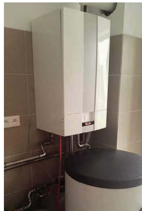
❗ Modele jednofunkcyjne podgrzewają wodę w zasobniku, dzięki czemu domownicy mają do dyspozycji dużą ilość ciepłej wody użytkowej. WOLF TECHNIKA GRZEWCA
