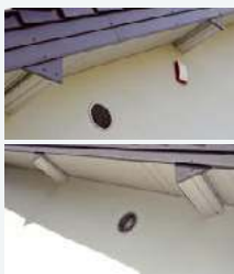
Czerpnię zamontowano na północnej ścianie budynku a wyrzutnię powietrza na południowej.
