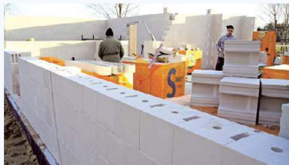
📌 Bloczki wapienno-piaskowe wymagają ocieplenia. Muruje się z nich ściany dwu- i trójwarstwowe. H+H
