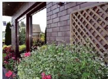
🔴 Do cieniowanej cegły w odcieniu śliwki dobrano podbitkę i dachówki.
