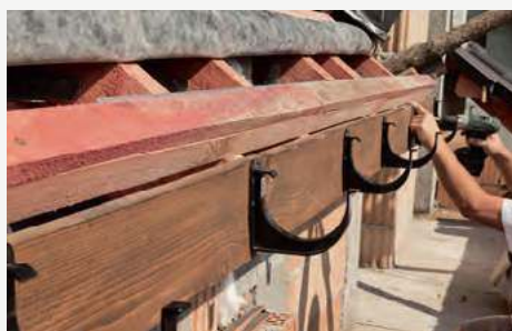
❗ Rozstaw rynhaków musi być dopasowany do materiału, z jakiego wykonane są rynny. RÖBEN
