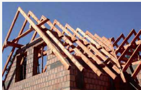
🔧 Bardzo ważne, aby elementy do wykonania więźby nie miały wypaczeń, śladów sinizny, zgnilizny i wypadających sęków. Od jakości drewna zależy bowiem trwałość konstrukcji. BUDOMAX
