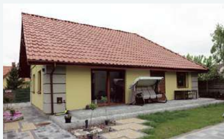
Styromury wykończono żółtym tynkiem silikonowo-silikatowym.
