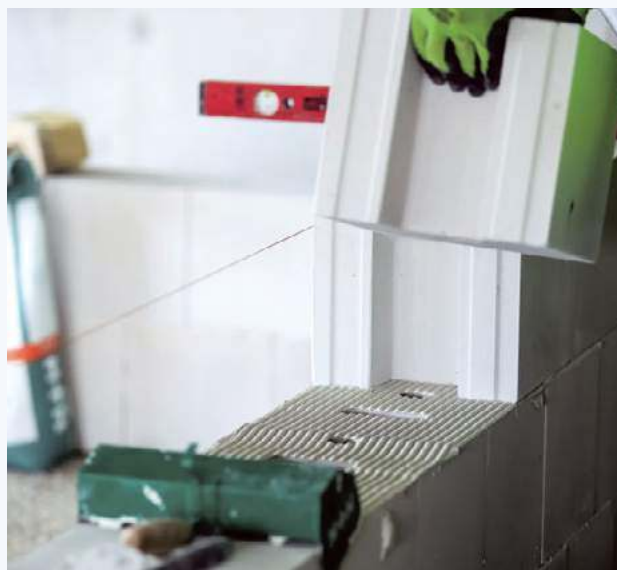
📌 Bloczki z betonu komórkowego o gęstości 500–700 kg/m 3 przeznaczone są do murowania ścian dwu- i trójwarstwowych o grubości 24 cm. H+H
