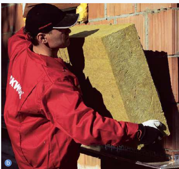
📍 Ceramikę oraz silikaty można ocieplić styropianem (a TERMO ORGANIKA) albo wełną mineralną (b ROCKWOOL).
