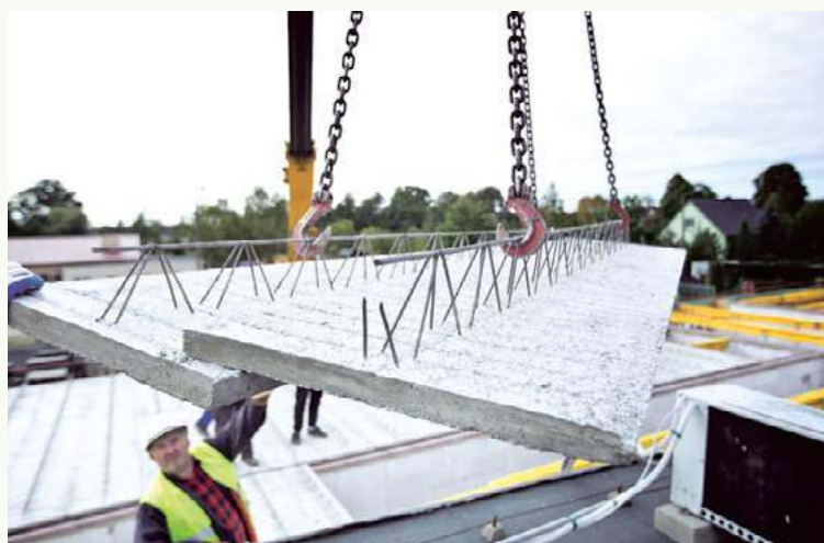
📍 Prefabrykowane płyty stropowe układa się bezpośrednio na ścianach nośnych i podciągach za pomocą dźwigu. KONBET
