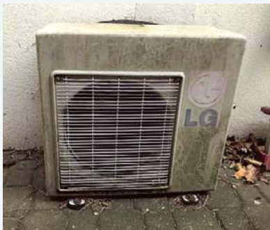
➤ Stojącą jednostkę zewnętrzną zamontowano w zacienionym miejscu.
