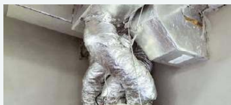
Od centrali poprowadzono zaizolowane rury.
