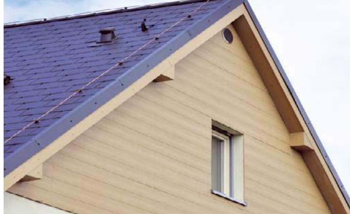
Deski z włóknocementu imitujące drewno są znacznie trwalsze od naturalnego surowca i nie wymagają konserwacji. CEDRAL
