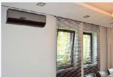
📍 Ściennej jednostkę wewnętrzną typu smart z jonizacją zawieszono w jadalni.
