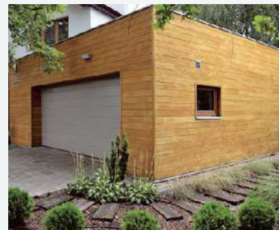
🔗 Oblicówkę z drewna ułożono poziomo, na wpust i pióro.
