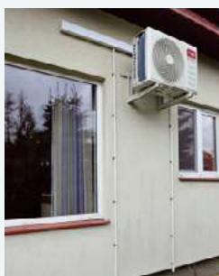
➊ Jednostka zewnętrzna na północnej ścianie.
