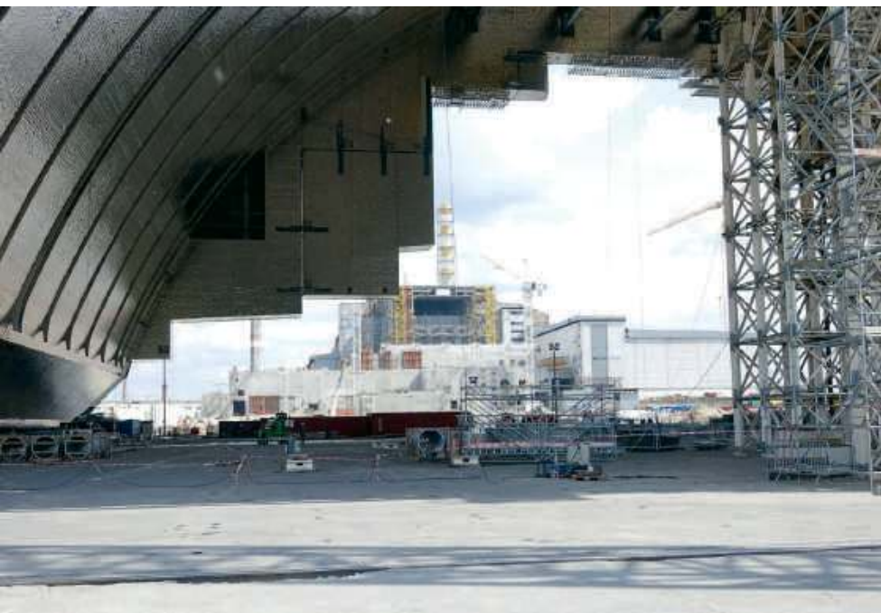
Elementy sarkofagu Arka, przygotowane do nasunięcia na uszkodzony blok w Czarnobylu, 2016 r.
