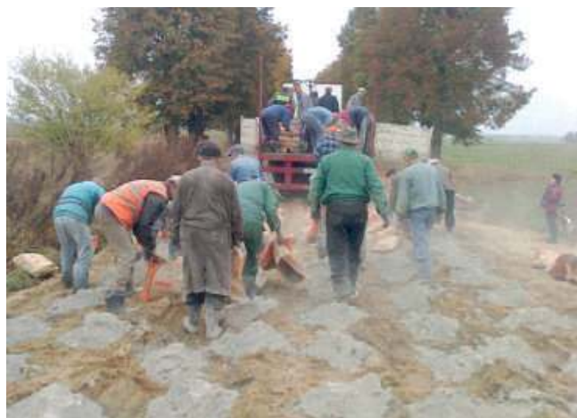
Budowa z drogi z Płudów do Radzyna (pomoc Mieszkańców)
