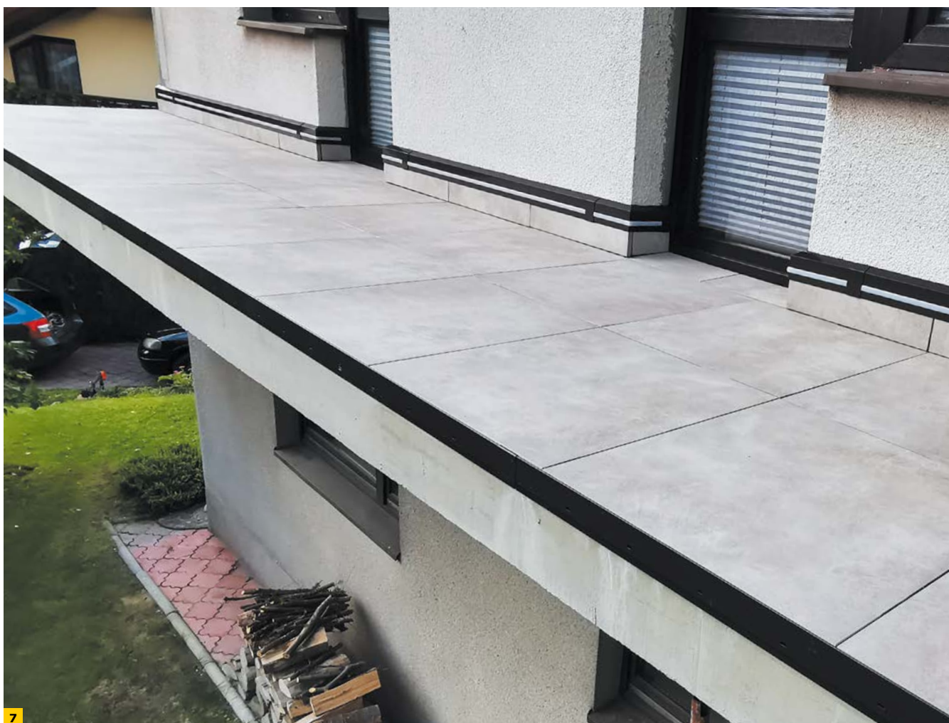
FOT. 6-7 Balkon przed (6) i po renowacji (7); fot.: Renoplast
