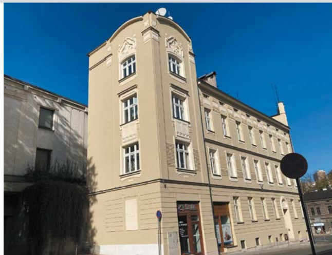
FOT. 7 Budynek wielorodzinny w Cieszynie; fot.: Barbara Panak
