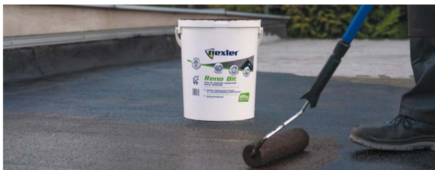
FOT. 1 W wielu przypadkach wystarczy renowacja powłokowa
