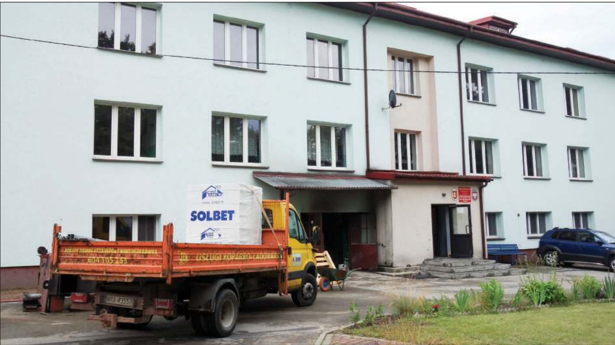
W budynku po byłym internacie, w którym na powstać klub seniora, trwa remont. Udało się już wymienić instalację grzewczą
