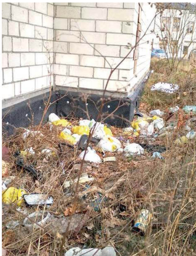
Śmieci przy Alejach Kościuszki. Składowisko po części znajduje się na terenie miasta, część leży na prywatnej działce
